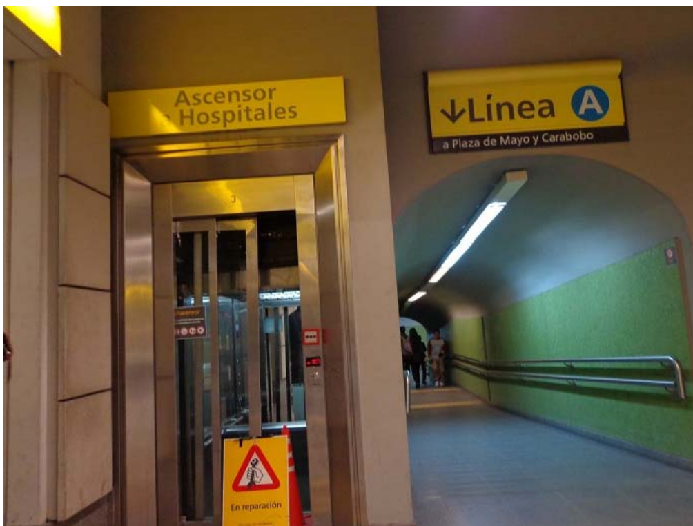
Ascensores y escaleras fuera de servicio en estación Hospitales - Línea H
