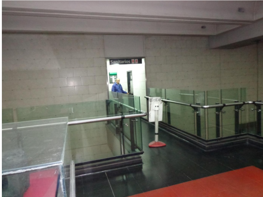
Baños cerrados en estación Congreso de Tucuman - Línea D
