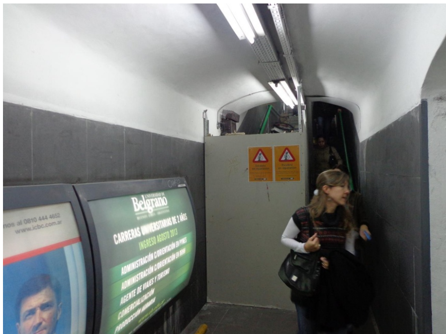
Única escalera fija en obra y en funcionamiento para subir y bajar con un paso para usuario de 0.60cm. F. de Medicina – Línea D
