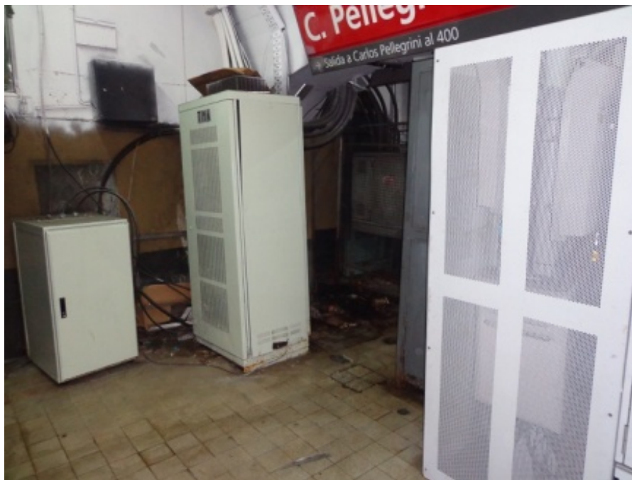
Filtración de agua en cielorraso y paredes afectando equipos electrónicos. C. Pellegrini - Línea B
