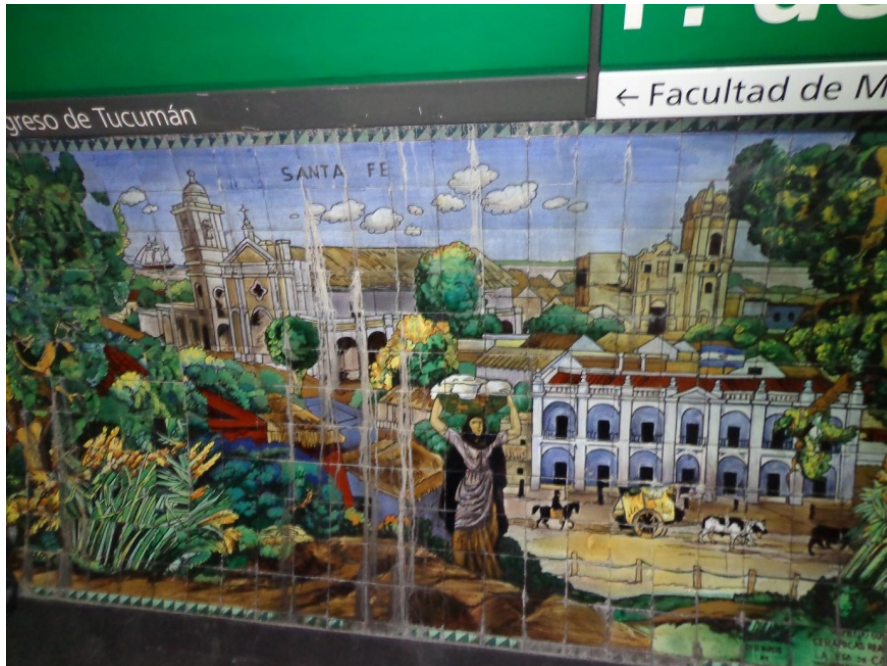
Murales e infraestructura en general mal mantenida. F. de Medicina – Línea D
