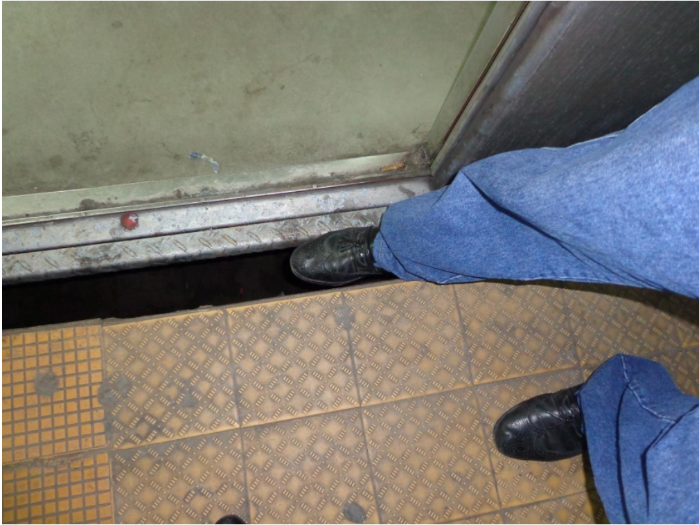
Separación entre coche y andén. Constitución – Línea C
