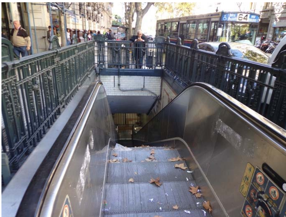
Escalera fuera de servicio, estación Perú - Línea A
