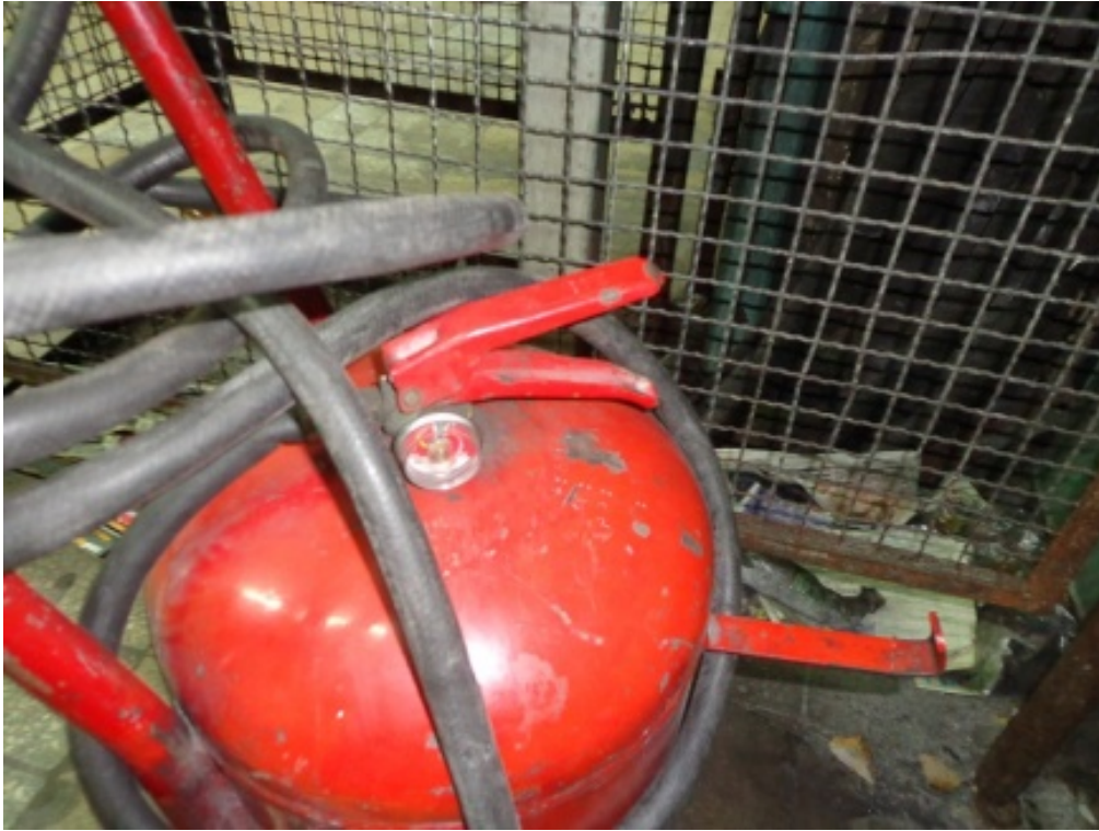
Carro polvo descargado y en mal estado de conservación. C. Pellegrini – Línea B
