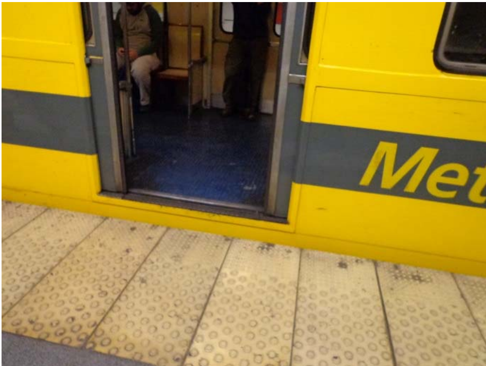
Diferencia de nivel de piso entre coche Siemen y andén. Humberto 1° - Línea H
