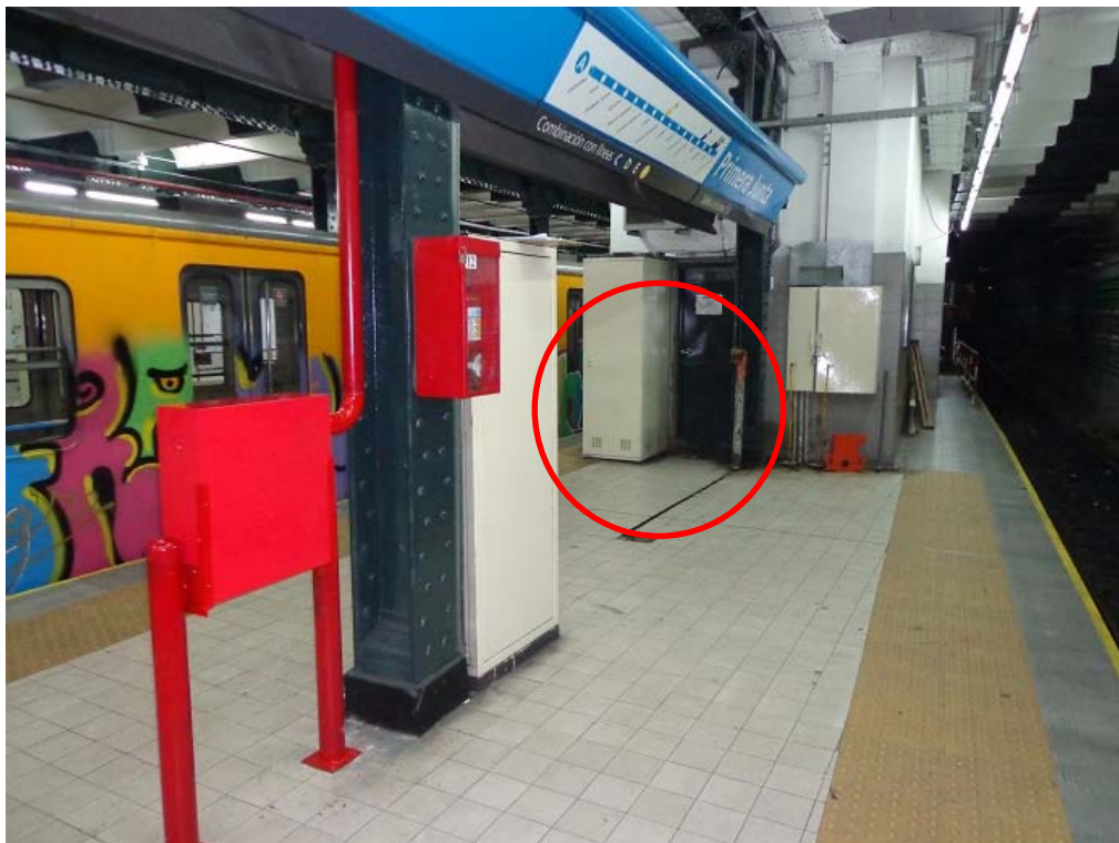
Instalación de incendio fija preexistente y en desuso. Primera Junta - Línea A
